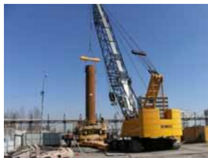
NSエコパイル回転圧入鋼管杭施工
