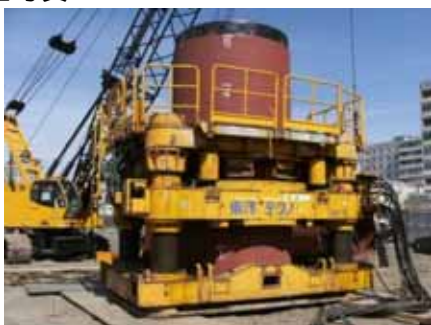
オールケーシング全周回転杭施工
