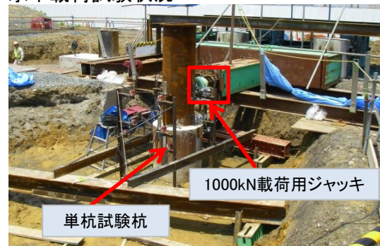
単杭載荷装置写真
