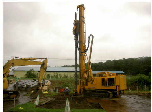
基地局施工写真(施工機械: DHJ25)
