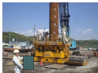
鋼管(下杭)建込み
