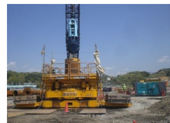
土投入(鋼管内)
