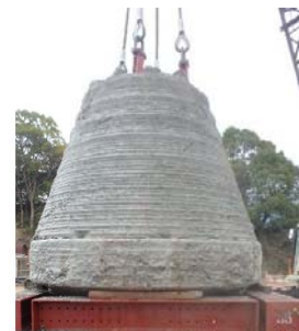
軸部径1.8m/拡底径3.5m 掘削長15.0m 土質(頁岩・砂岩)
