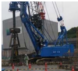
◁ 拡底部掘削状況
