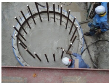
モルタル打設状況
