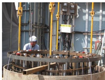
鉄筋かご建込み状況
