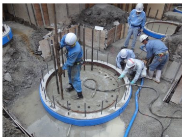
引張り定着筋挿入状況
