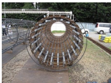
鉄筋かご出来形
