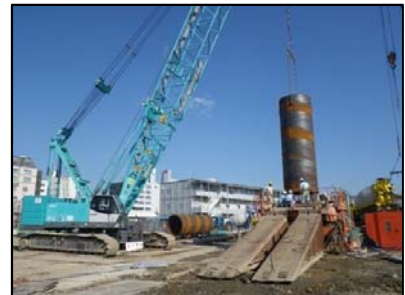
鋼管建込み状況
