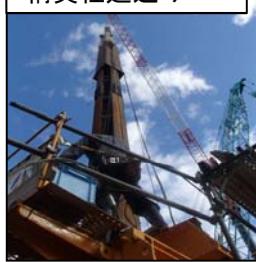
構真柱建込み
