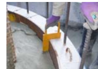
グラウト天端 確認用治具使用状況
