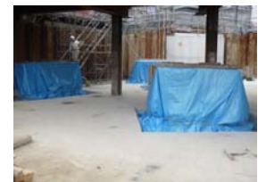
グラウト打設後養
