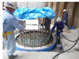
グラウト打設
