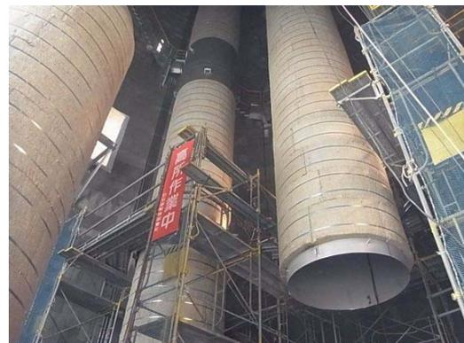
上部設置の油圧ジャッキにて吊上げ状況
