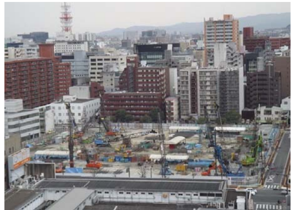
(KCTB場所打ち鋼管コンクリート杭)
