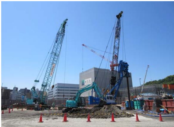
(new ACE工法最大拡底径φ4.8m施工)
