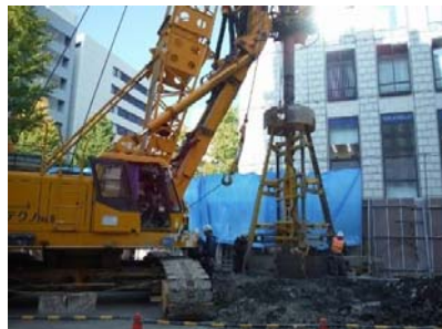
拡底部掘削状況
