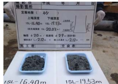
定着地盤および定着長確認
