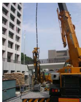
基本試験 アンカー施工状況
