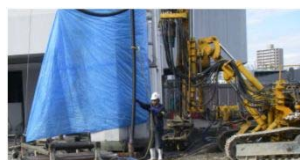
削孔打設状況
