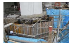
本設補強基礎部
