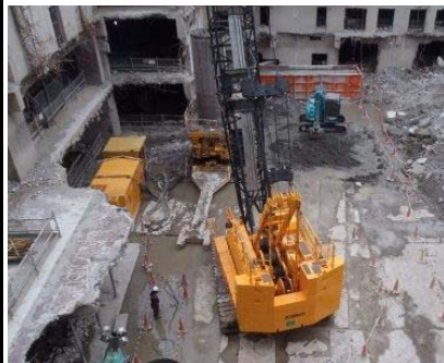
既存建物地下3階での施工状況
