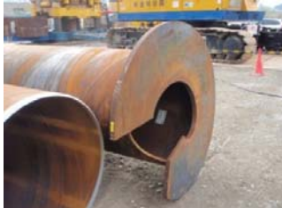
NSエコパイル工法 杭先端羽根部形状
