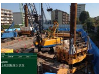
鋼管上杭 回転圧入状況 φ800mm
