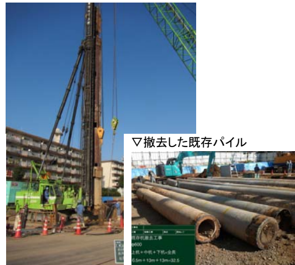
△既存パイル撤去状況
