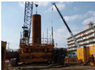
鋼管回転圧入状況
