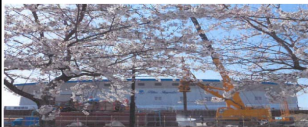
満開の桜の中での杭施工
