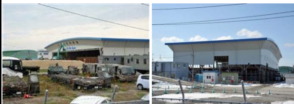
曳き家後の盛土・整形状況
