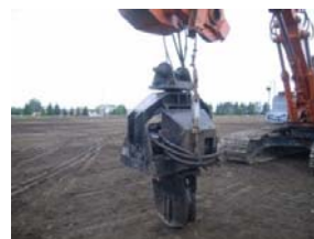
押込み試験状況
