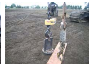
引抜き試験状況
