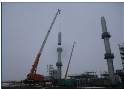
写-4) 現場施工状況(建方)
