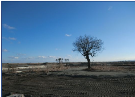
写-3) 施工現場(着工前)
