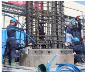
写真2) 地中熱採熱管建込み状況
