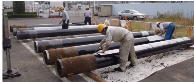
SLシート材貼付け状況
