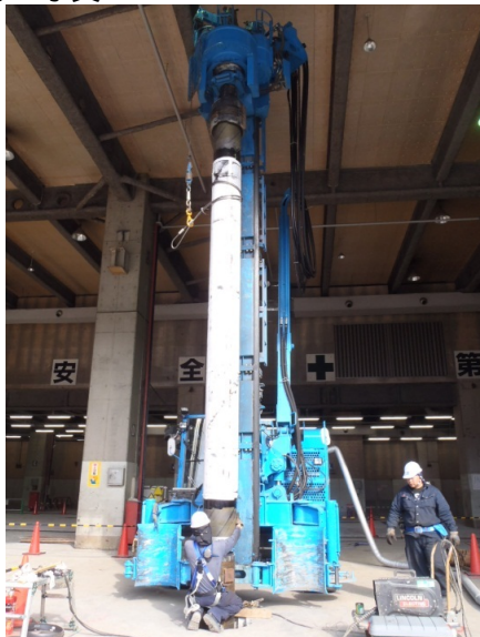
鋼管建込み状況
