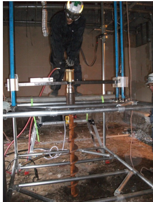
写真-3)鋼管回転圧入状況
