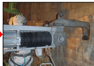
内部煉瓦解体(電動ジャッキ)状況
