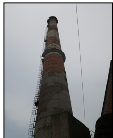
80m煙突解体前
