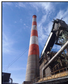
100m煙突解体前
