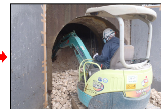
解体煉瓦搬出状況
