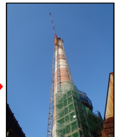
仮設設備(全景)
