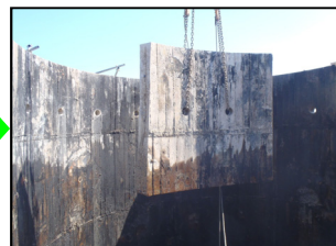
解体した躯体をブロックで撤去状況
