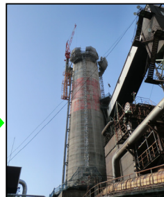
躯体解体状況
