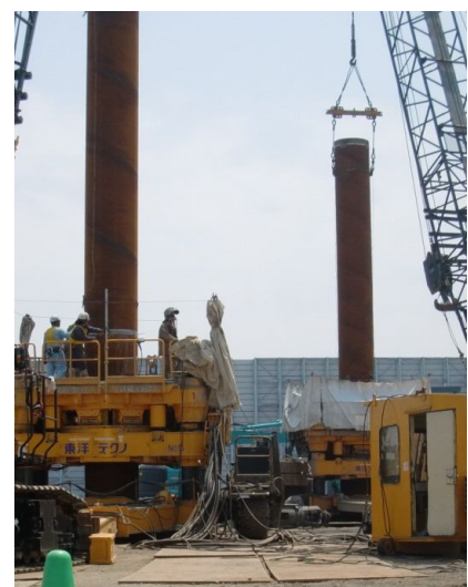
NSエコパイル 鋼管建込み状況
