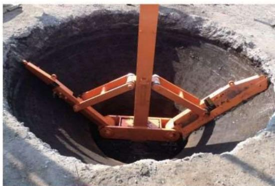
中間拡径下部の浅層掘削試験 掘削後 拡径部径φ4.8m (中間拡径下部底ざらい状況) 軸下部径φ2.2m
