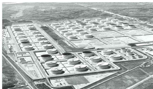
国家備蓄タンク
