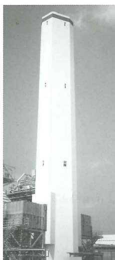
美浜シーサイドパワー㈱ 新港発電所 59m煙突
