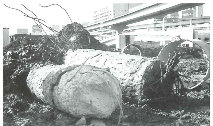
撤去された場所打ち鉄筋コンクリート杭
