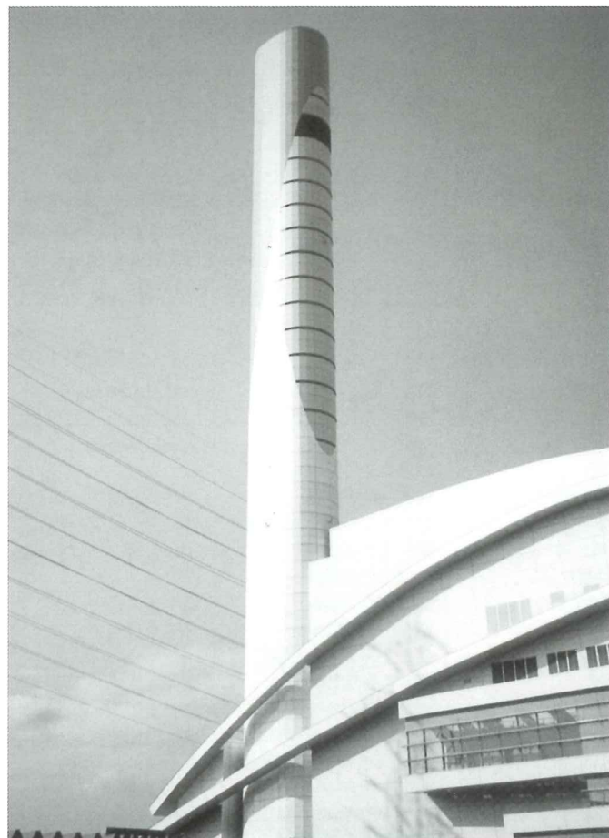
大阪市平野清掃工場 (煙突工事)
