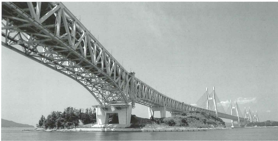
瀬戸大橋 (リバース工法)
