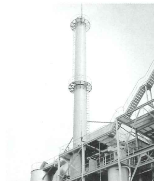
㈱白河ウッドパワーバイオマス 発電設備 45m煙突
