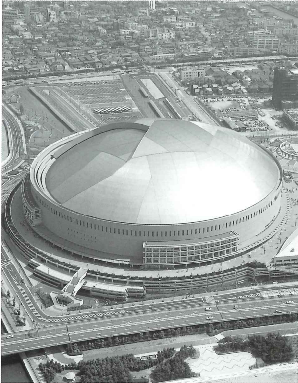
福岡ドーム (ACE工法)
