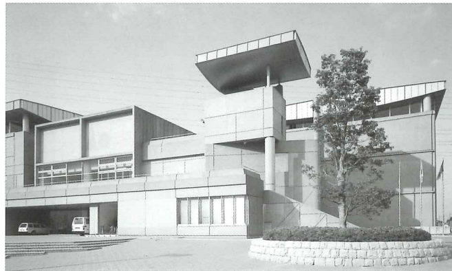
海老名市総合体育館 (CD工法)
