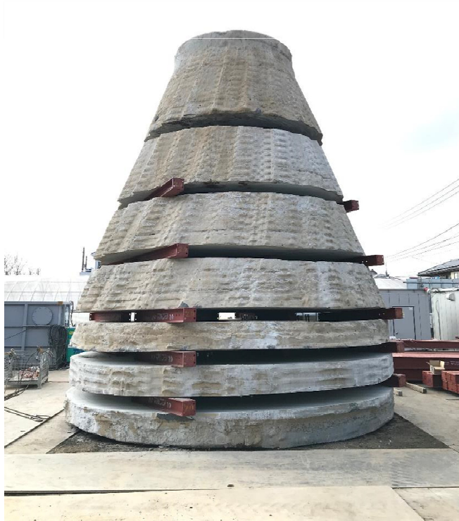
拡底杭 掘り起し状況 (拡底径 6,100mm)
