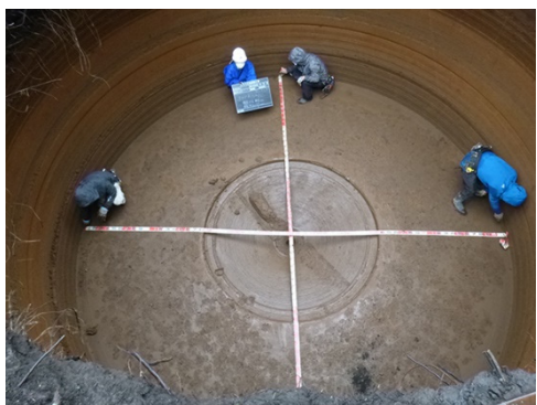
拡底バケットによる掘削実験
